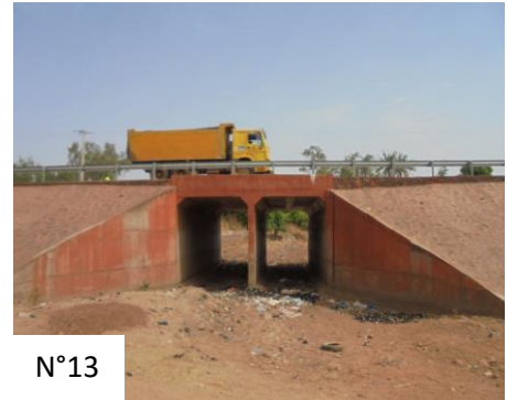
Ouvrage d'art sur la RN6
