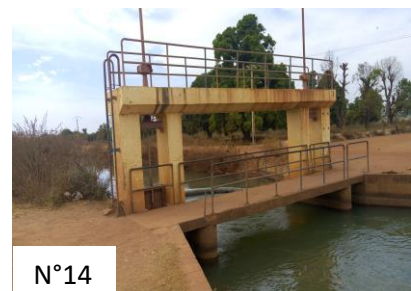
Régulateur d'eau sur le canal
