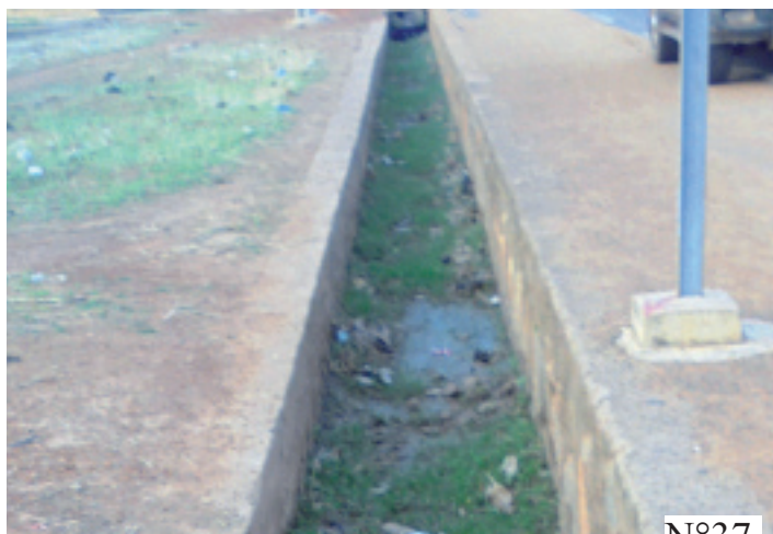
Caniveau en maçonnerie de pierre
