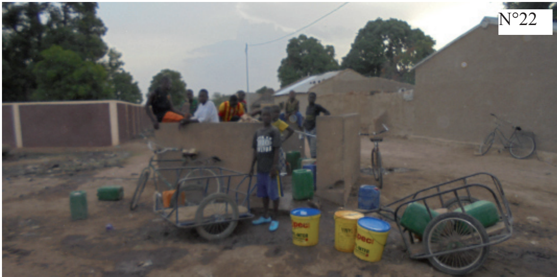
Forage équipé de pompe manuelle
