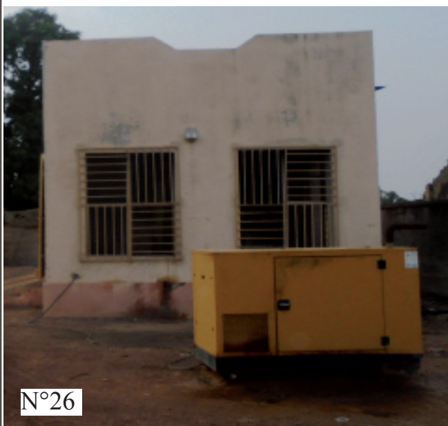
Générateur électrique (250 KVA)
