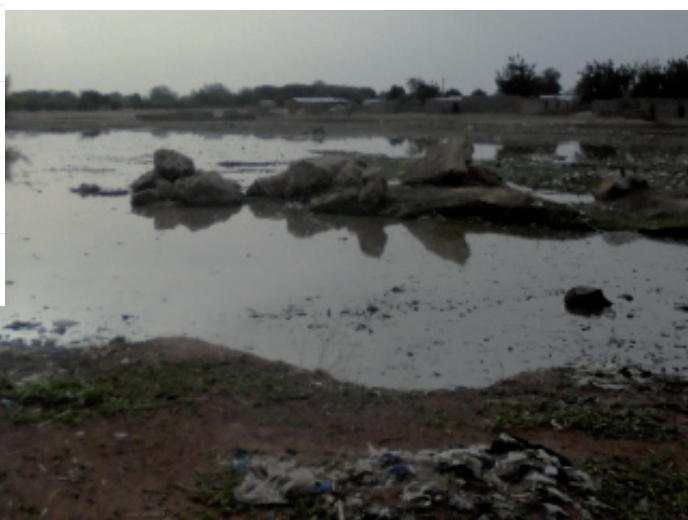
Dépression due à l'aménagement de la RN 26
