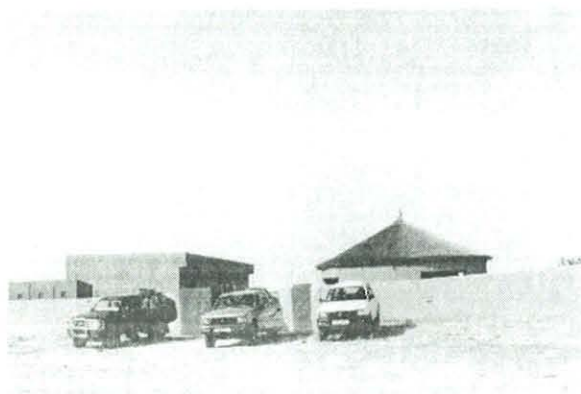
Habitat moderne : Centre d'accueil
