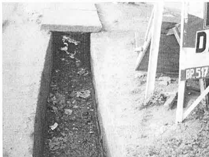
Caniveau de la voie n° 1
