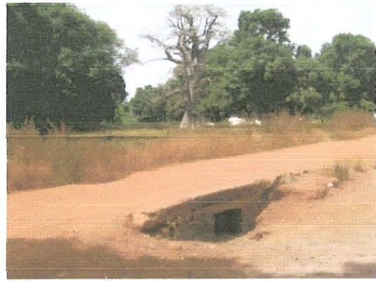
Ouvrage d'art en face de la forêt sacrée
