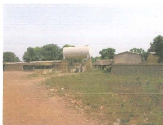
Château d'eau du Projet Danois
