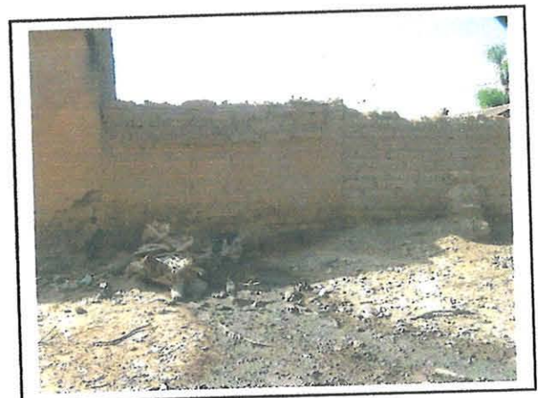
Eaux usées dans la rue
