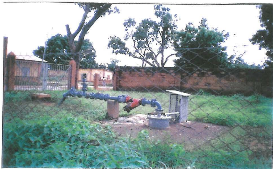
Point de pompage d'eau
