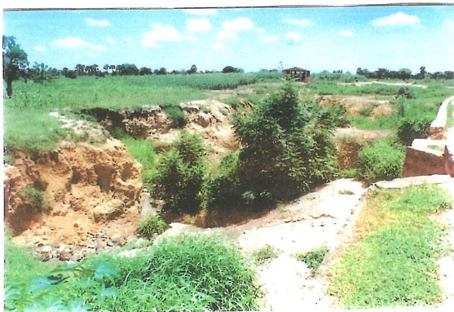
Erosion du sol
