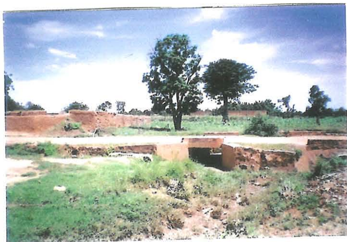
Ouvrage d'art sur route de Banamba
