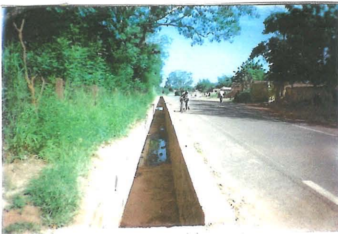
Caniveau maçonné le long de la RN3
