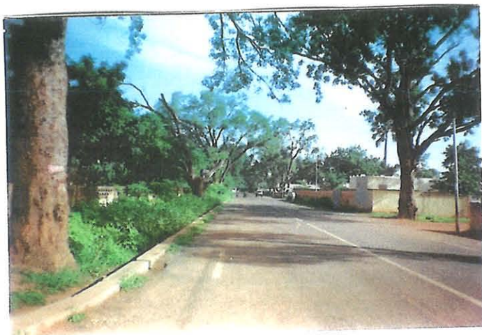
Route nationale (RN3) en bitume
