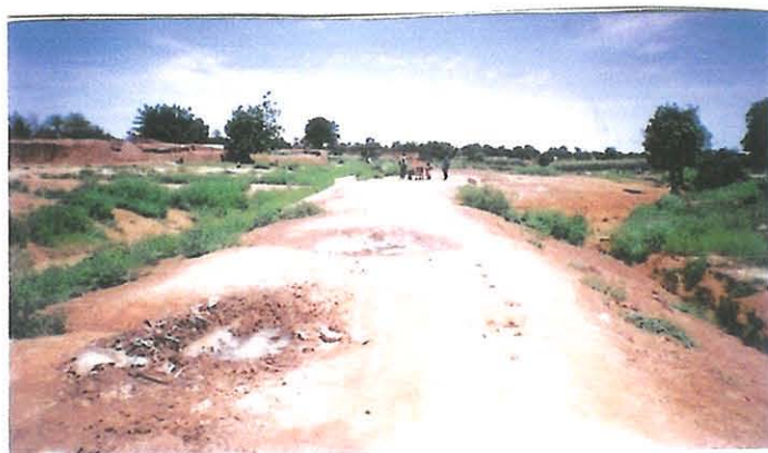
Route de Banamba (R L25) en latérite
