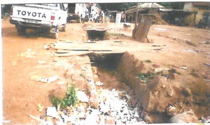
Caniveau maçonné le long de la RR21
