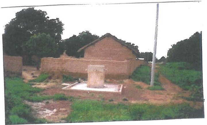
Borne fontaine du réseau principal
