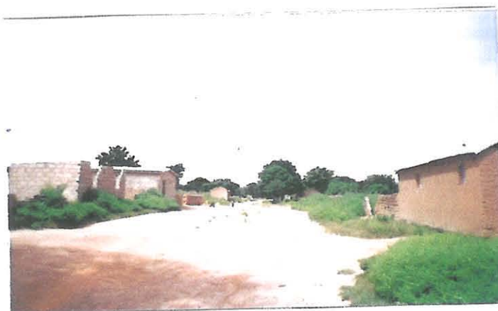
Voirie Secondaire (Route de Boundioba)
