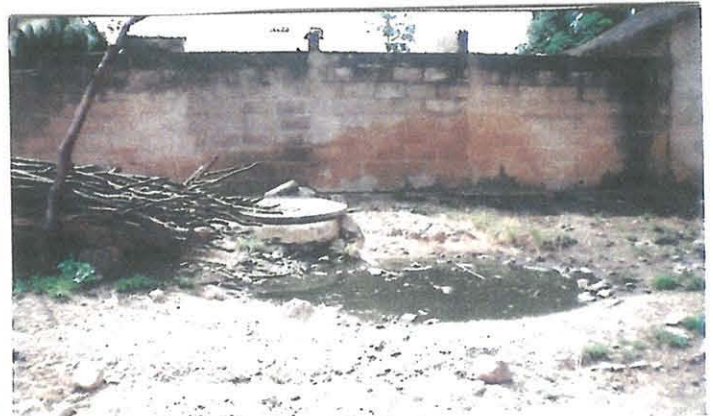
Puisard débordant dans la rue
