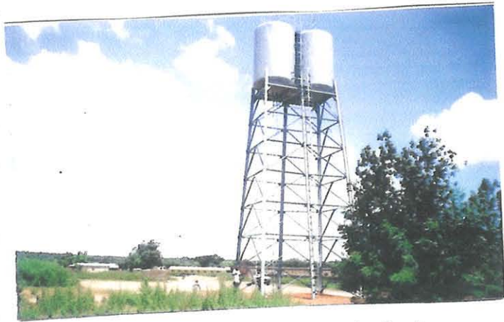
Château d'eau du réseau Principal
