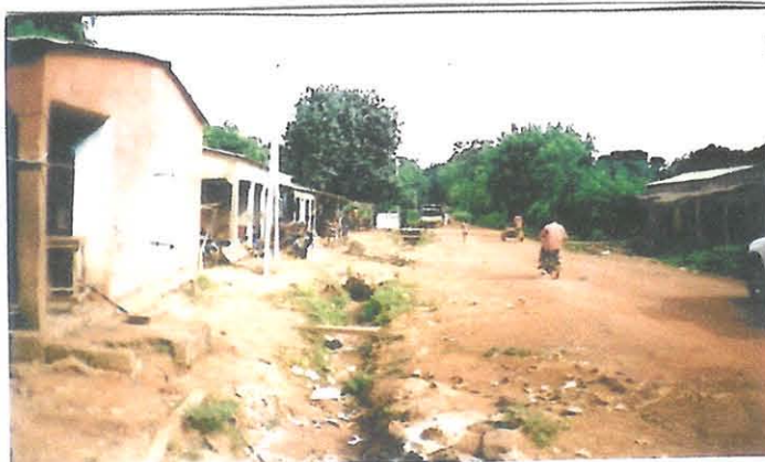
Caniveau non maçonné le long de la RR21
