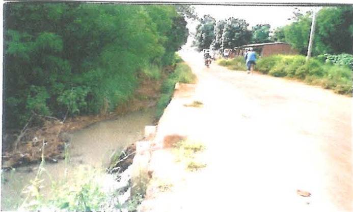
Ouvrage d'art sur le collecteur naturel
