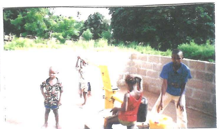
Forage à pompe manuelle
