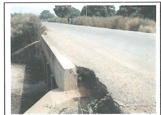
Pont en béton
