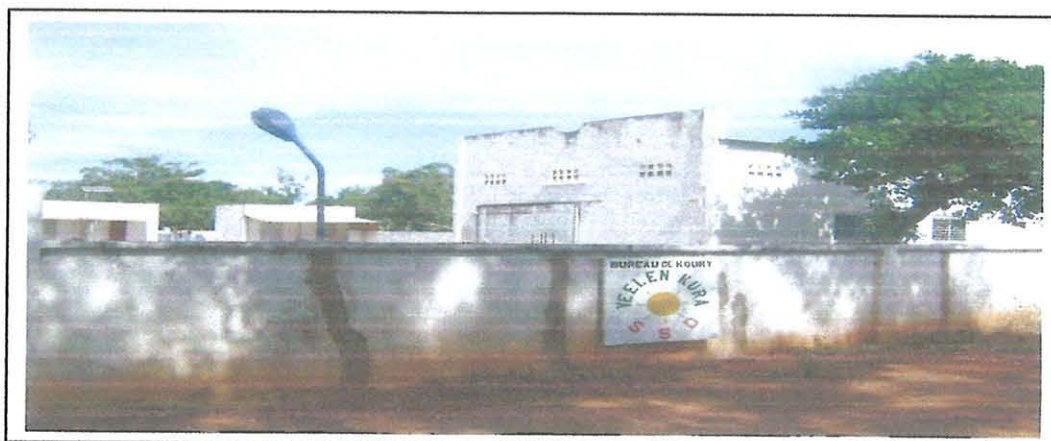
Centrale Electrique de Yeelen Kura
