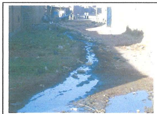
Ecoulement Eaux usées dans la rue
