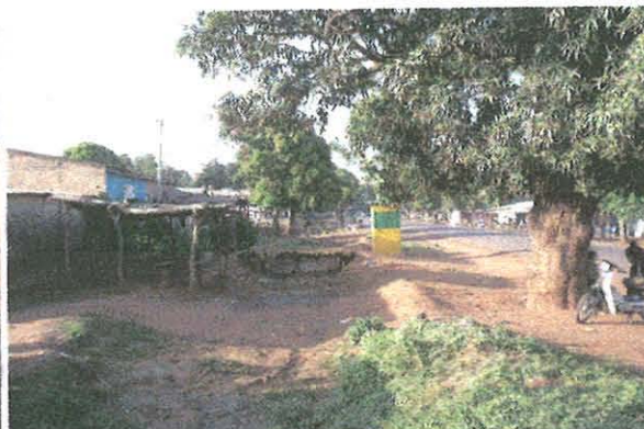
Ouvrage de drainage le long de la RN7
