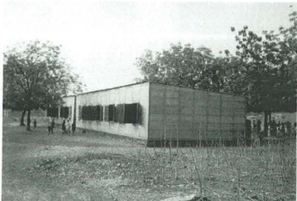
Salles de classes en préfabriqués à Ntintoubougou
