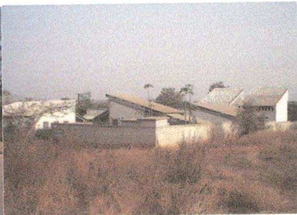
Station de pompage des eaux
