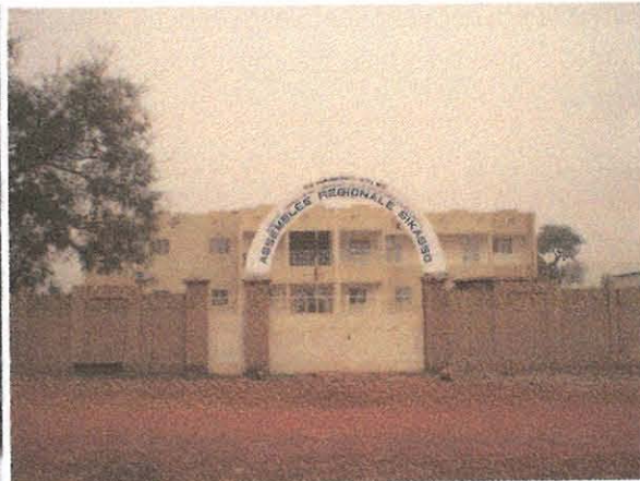
Bureaux de l'Assemblée Régionale dans la nouvelle zone de bureaux
