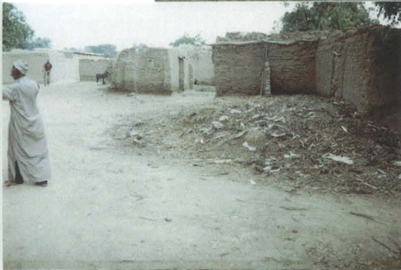
Tas d'ordures dans la rue
