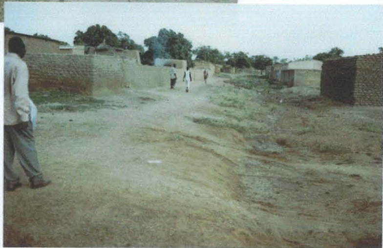
Voie servant de collecteur naturel
