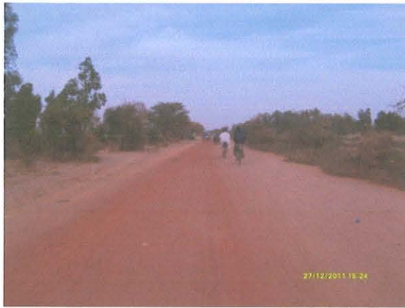
Photo n°1 : Voie secondaire Niougou-Dougabougou
