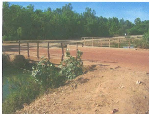
Photo n°6 : Pont en béton sur le canal mort près de l'usine
