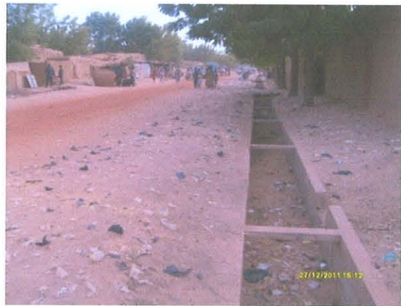
Photo n° 12 : Caniveau en béton près du marché
