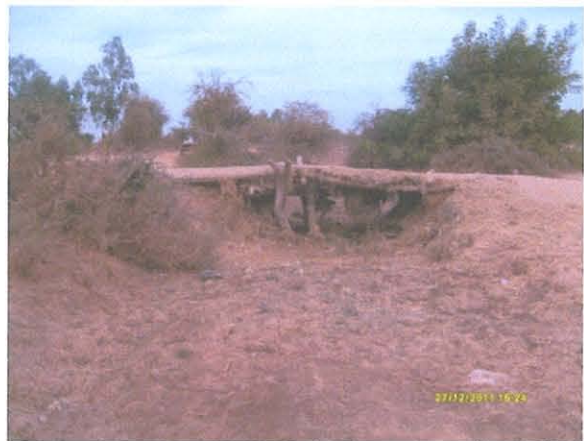
Photo n°4 : Pont en bois sur la tranchée drainante
