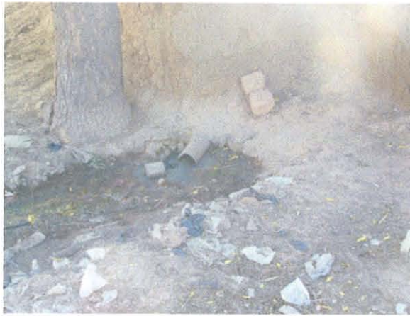
Photo n°11 : Rejet d'eaux usées dans la rue
