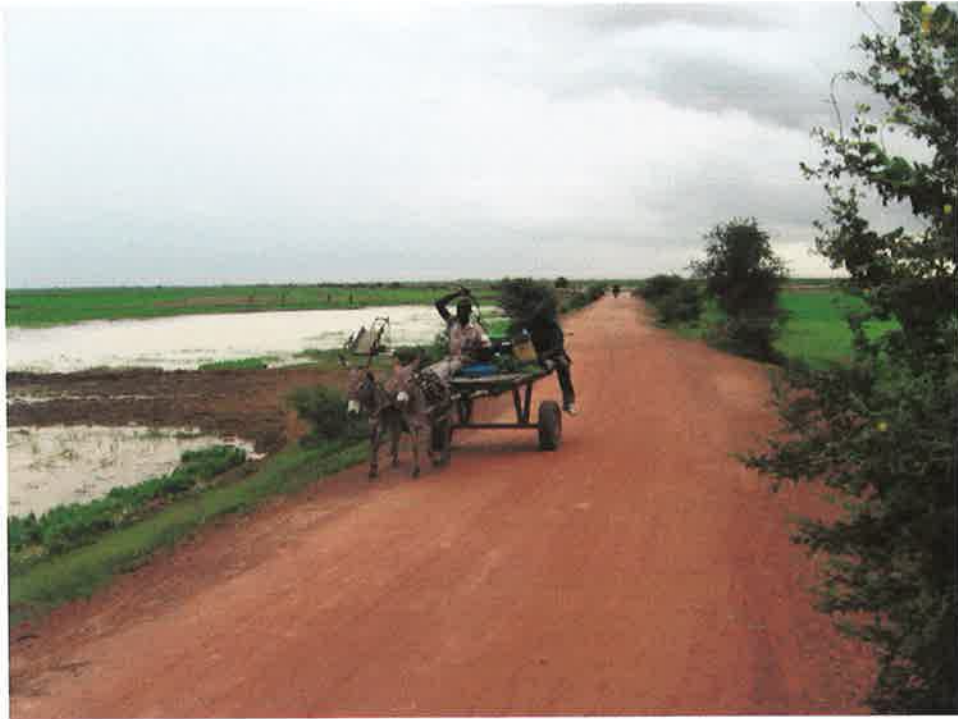
Voie digue de Béléniéni
