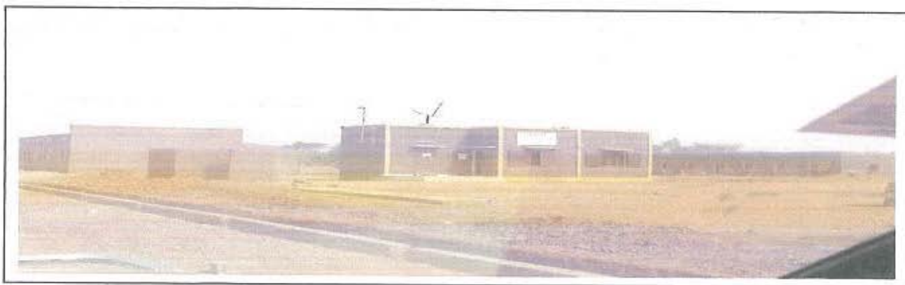
Centre Local d'Informatique et de Communication (CLIC)
