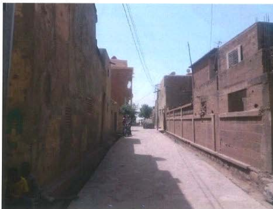
Photo N° 32: Caniveau dans une rue pavée de la vieille ville de Mopti
