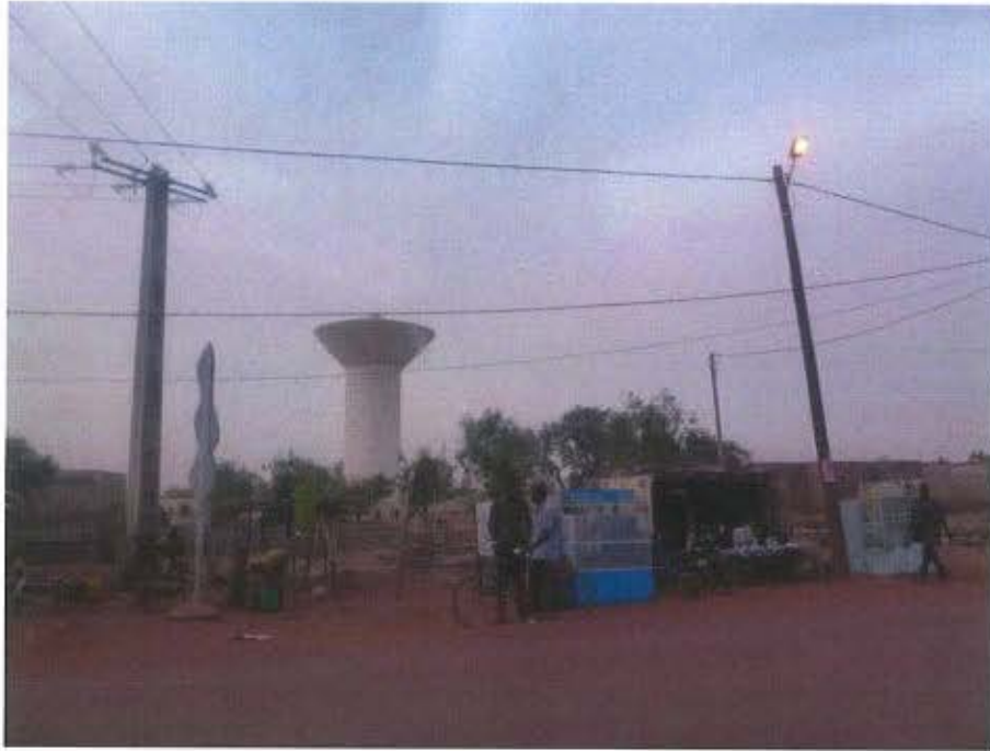
Photo N° 27 : Réseau d'électricité avec éclairage public et Château d'eau près du camp militaire à Sévarél
