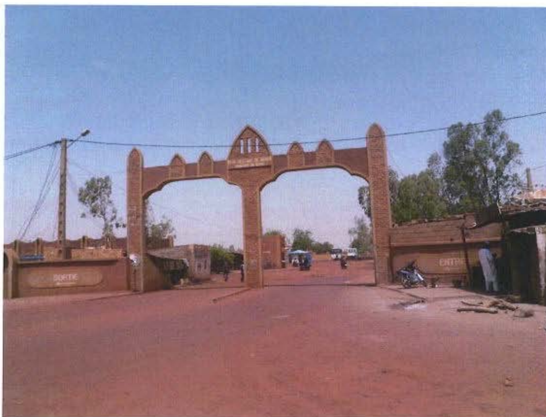
Photo N° 54: Gare routière de Sévaré II
