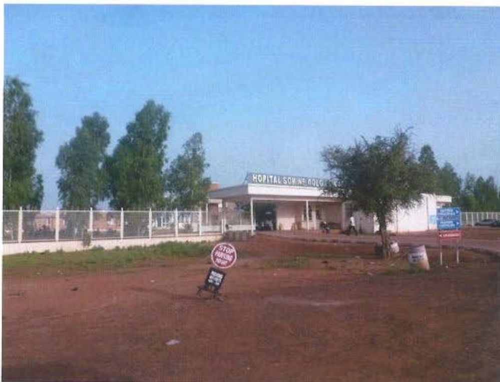
Photo N° 39: Hôpital Sominé DOLO à Sévaré
