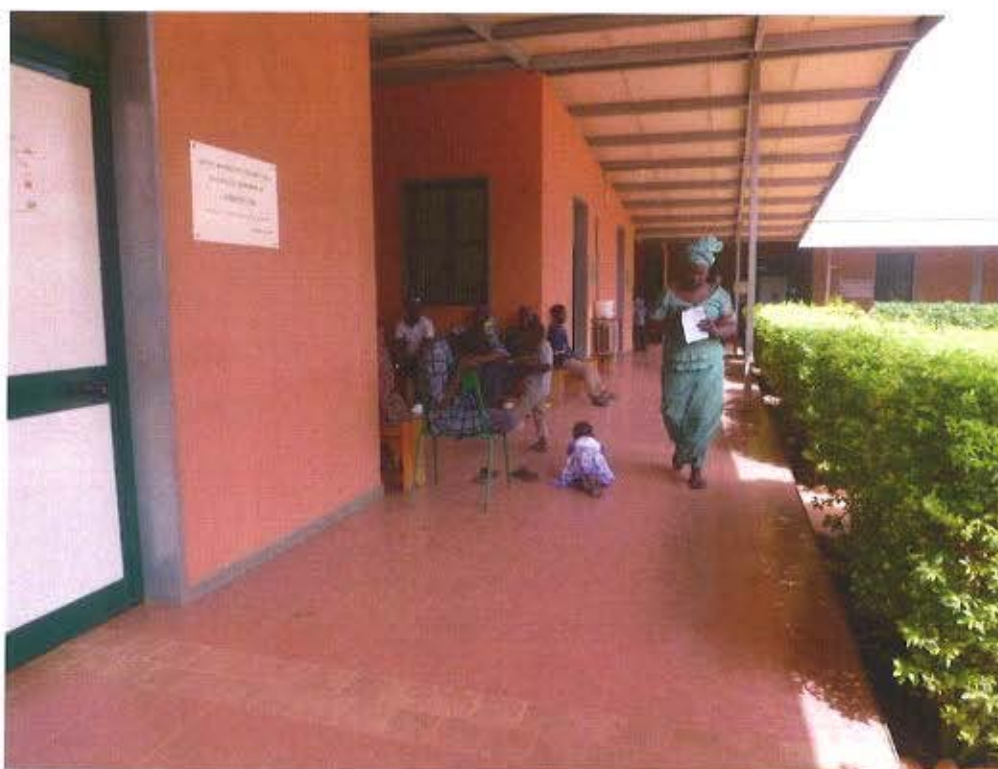
Photo N° 40 : Hôpital GAVARDO à Sévaré I
