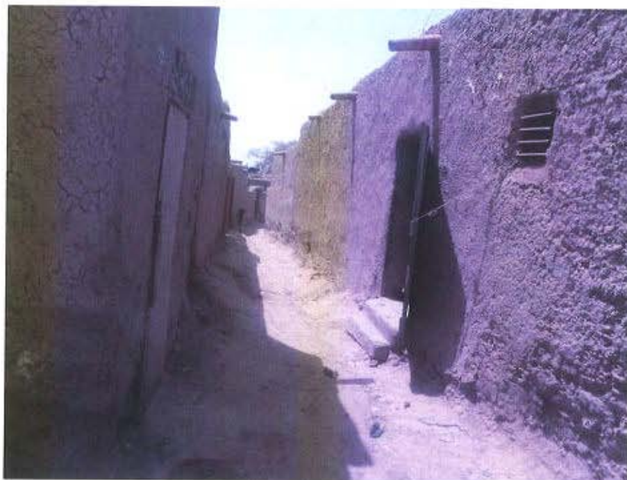
Photo N° 24 : Ruelle non aménagée
