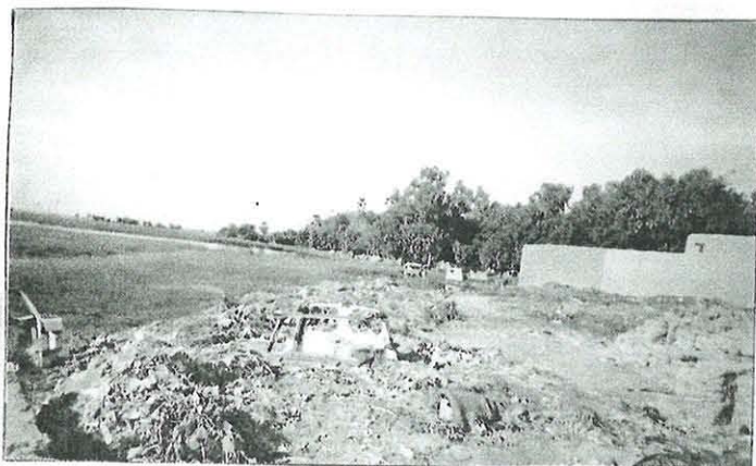
Terre obtenue par remblayage des zones inondables
