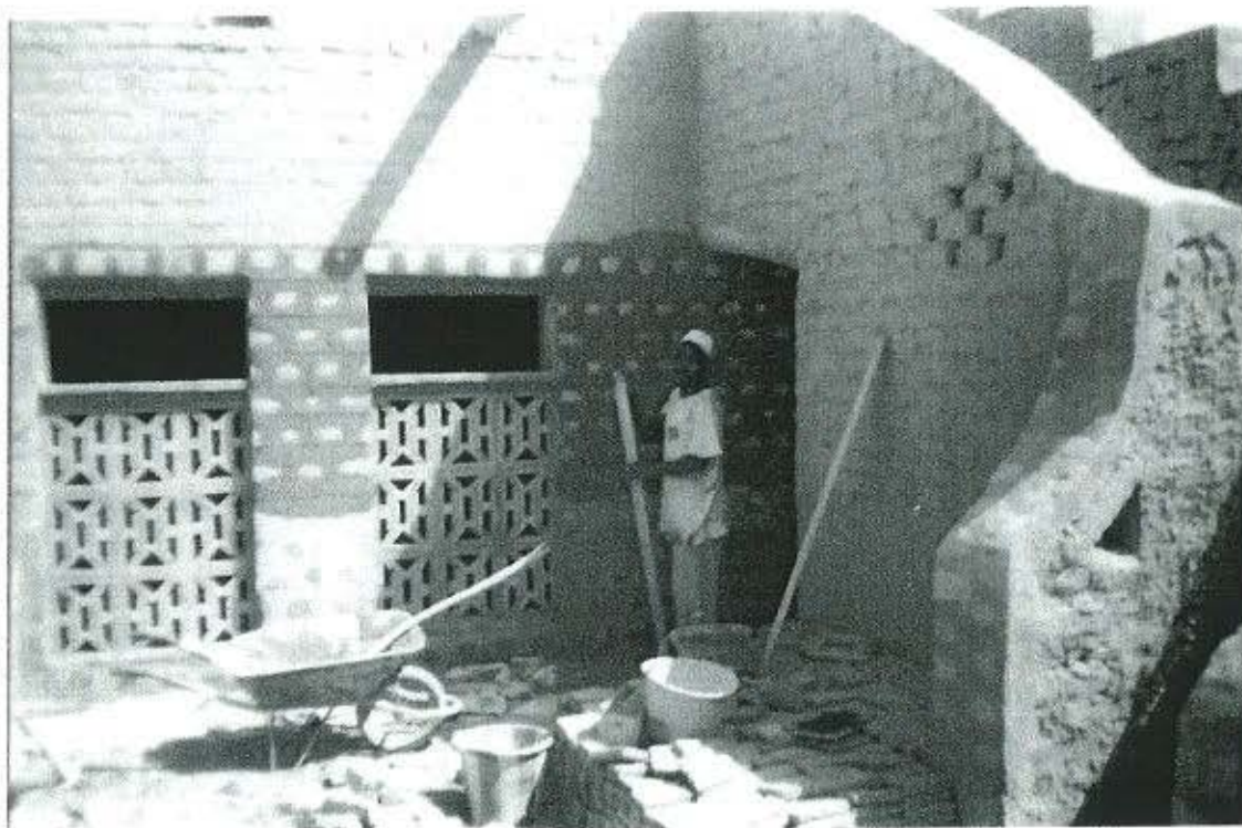
POSE DE BRIQUES ET DE CLAUSTRAS CUIITS
